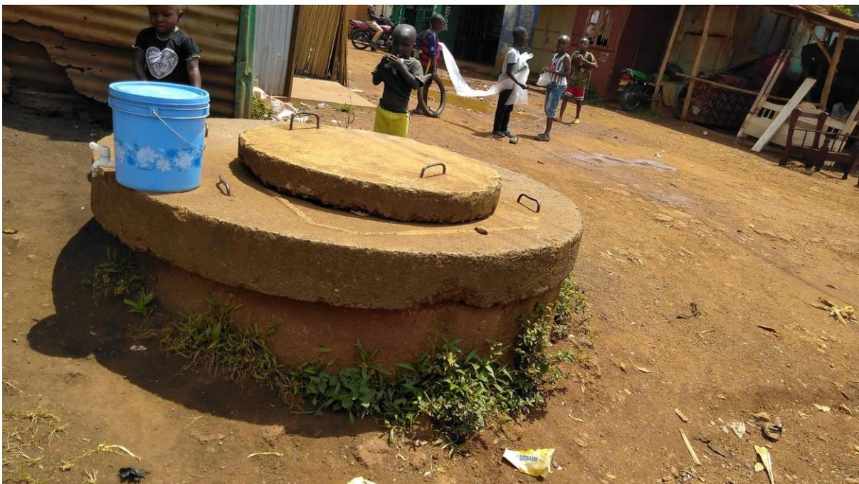
*Plate 9- 3: Sewer manhole*
